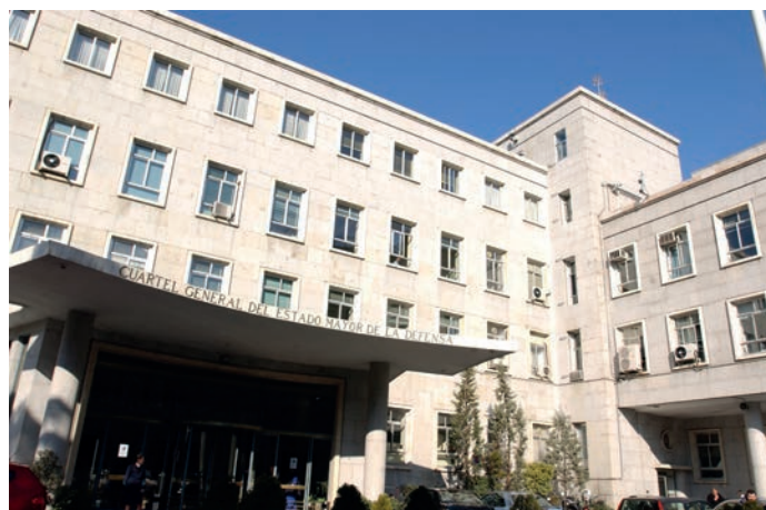
Entrada principal del EMAD, construido con hormigón armado y cubierto por granito gris de Colmenar Viejo.
