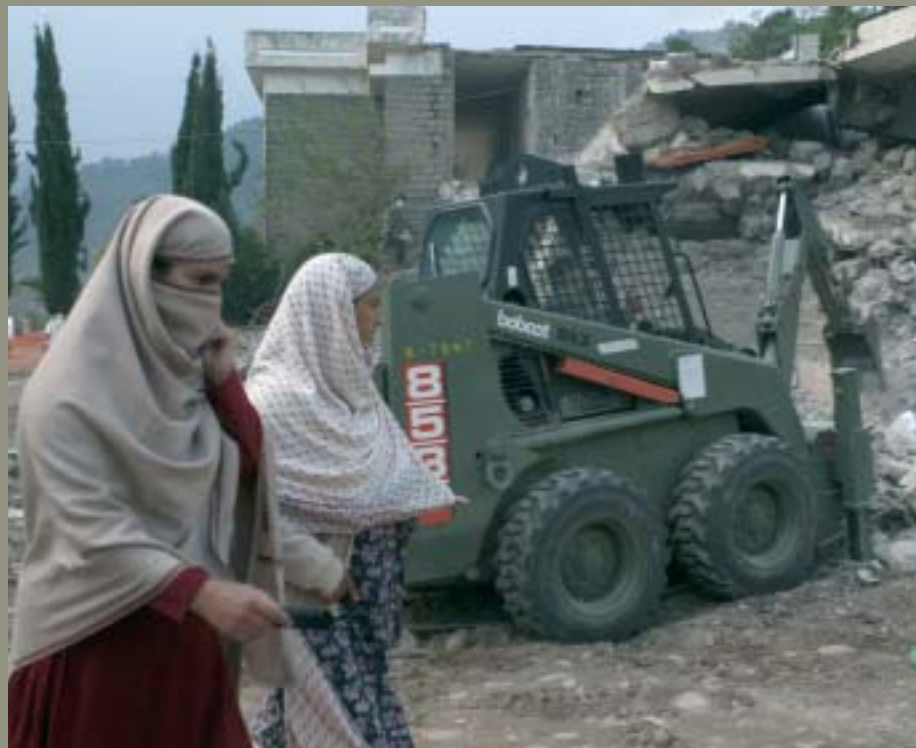
Las máquinas de la compañía de zapadores pueden convertirse en excavadoras, retroexcavadoras, empujadoras o palas de acuerdo con las necesidades de las tareas de reconstrucción.
